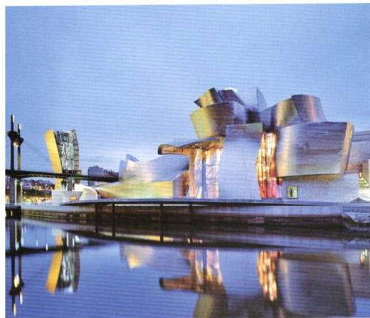
LA CONSTRUCCIÓN DEL MUSEO DE BILBAO DURÓ TRES AÑOS. SE DISTINGUE POR SER UN EDIFICIO DE MUROS DE TITANIO, PIEDRA CALIZA Y CRISTAL, 19 SALAS DE EXPOSICIÓN Y UN ATRIO ILUMINADO CON UN INMENSO CANDELABRO
